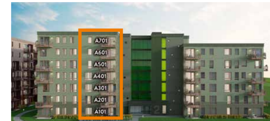
Bygg A, fasade mot nord
