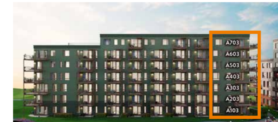
Bygg A, fasade mot sør
