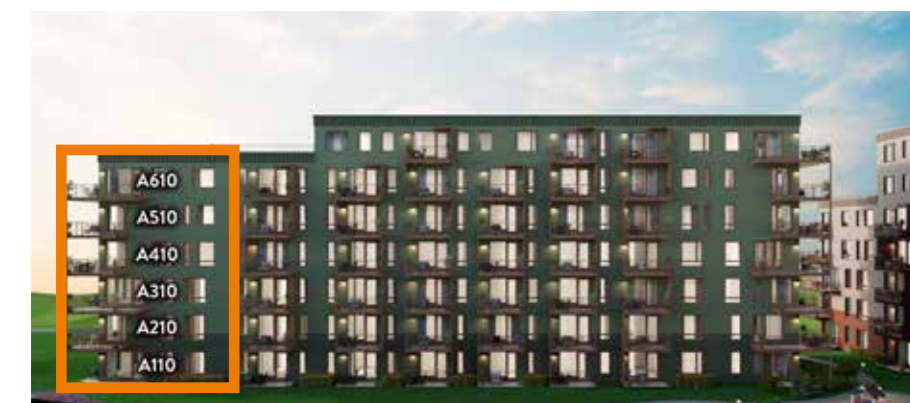
Bygg A, fasade mot sør
