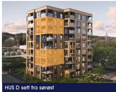
HUS D sett fra sørøst
