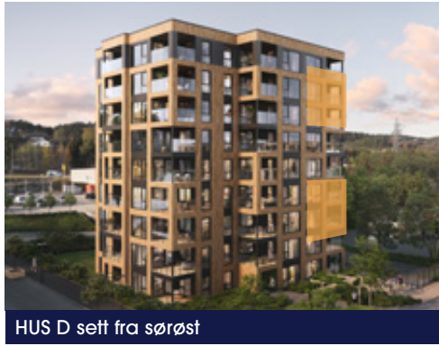
HUS D sett fra sørøst
