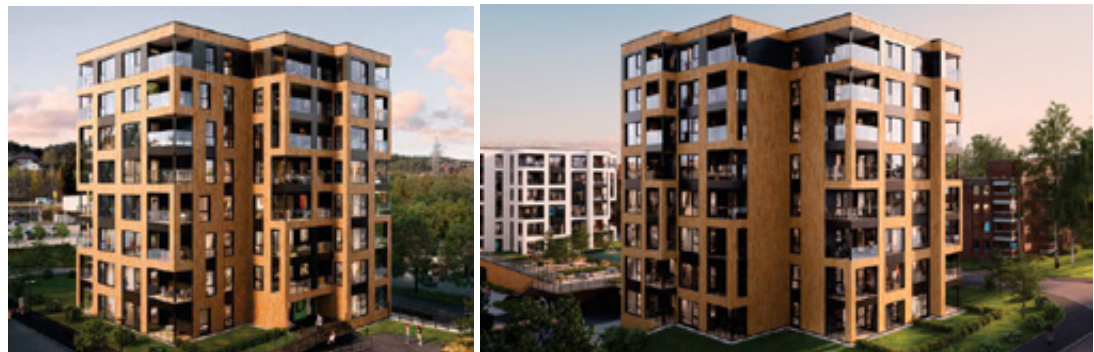
Hus D sett fra hhv sørøst og nordvest
