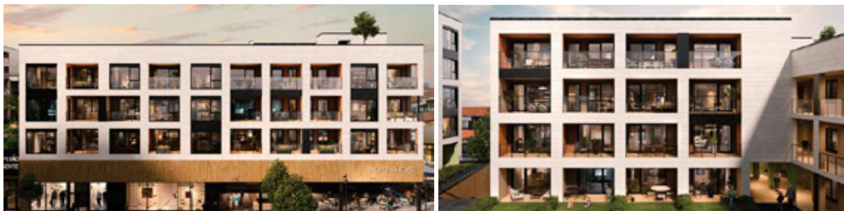
Hus C mot hhv torg (i sør) og uterommet
